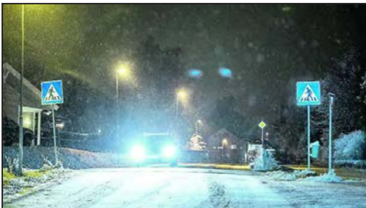
SKJEDDE HER: UAG-rapporten (t.h.) avdekket flere mangler ved gangfeltet i Enebakk der ulykken skjedde. Veien er nå bygget om.
