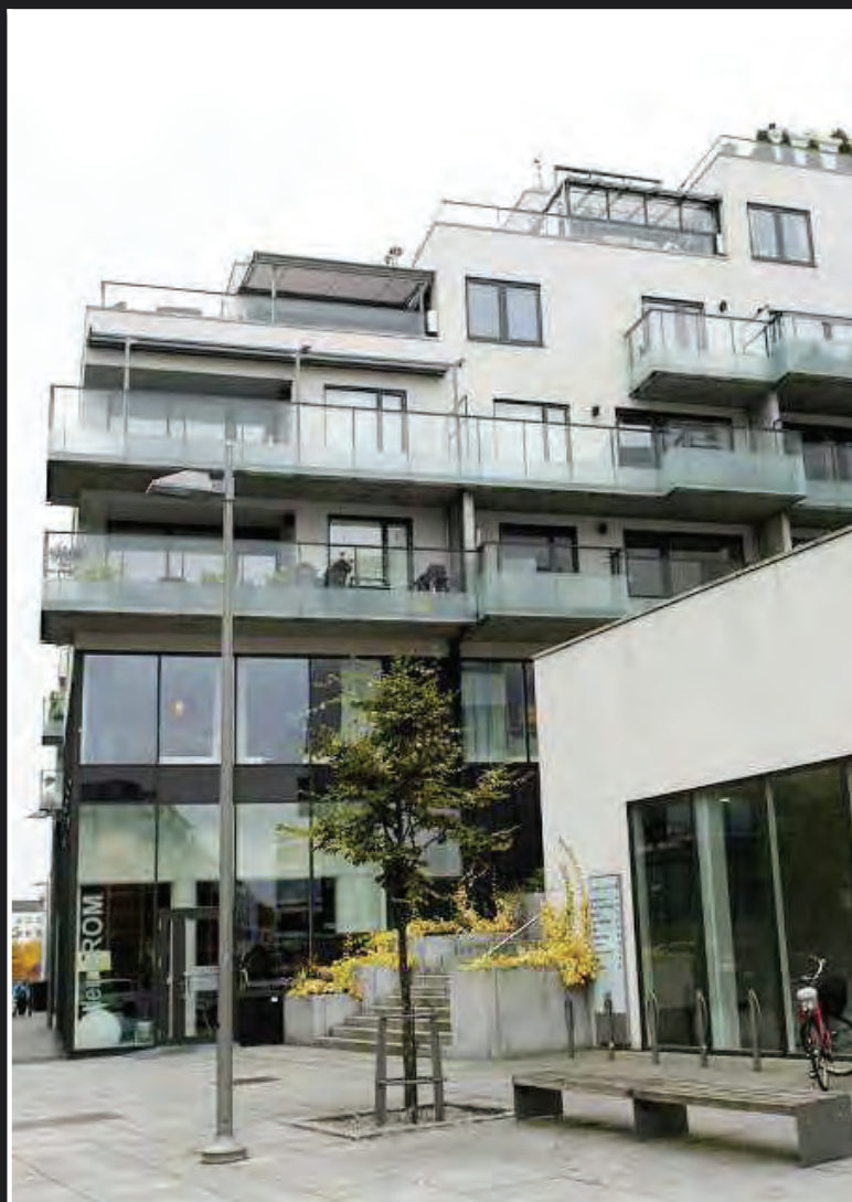
KAN SKRU AV VARME: Dagbladet fant styringssystemet for varmepumpa i Kvartal 10 utvikling bekrefter at vi kunne skru av varmepumpa, en av to varmekilder i kvartalet.
